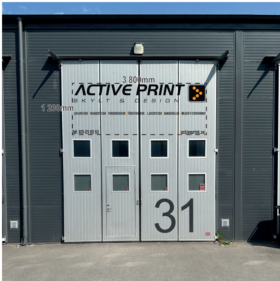
Fasad mot innergården
